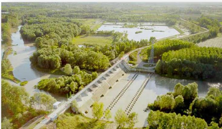
Cassa d'espansione sul fiume Panaro
